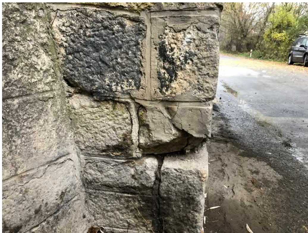
Fotografie č. 3: Detail mechanicky poškozeného nároží, místy je zde vyspravené spárování.
