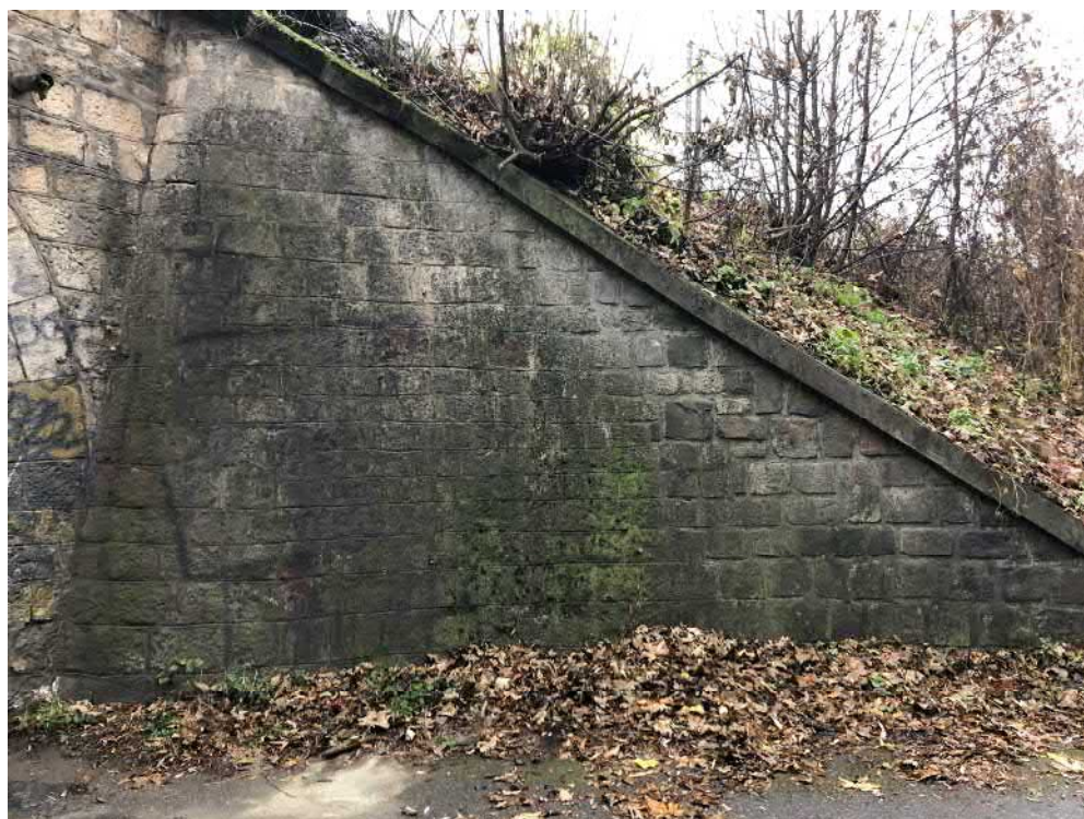
Fotografie č. 5: Pohled na opěru mostu ve směru Brno hl. n. Místy degradované spárování, mechanické poškození podhledu klenby.
