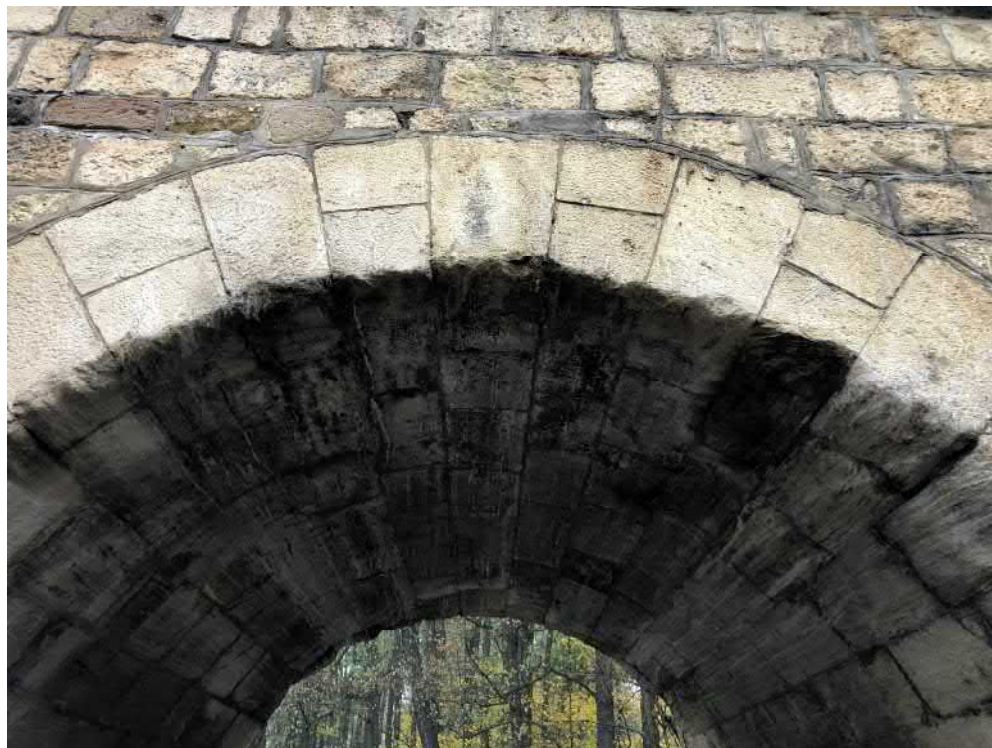
Fotografie č. 9: Pohled na kamennou klenbu. Je zde patrné mechanické poškození podhledu klenby od projíždějících nákladních vozů.
