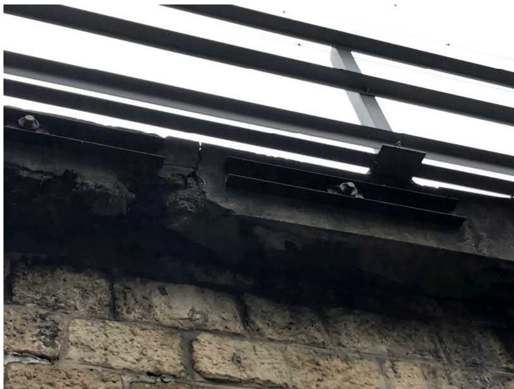
Fotografie č. 3: Detail mechanicky poškozeného nároží, místy je zde vyspravené spárování.
