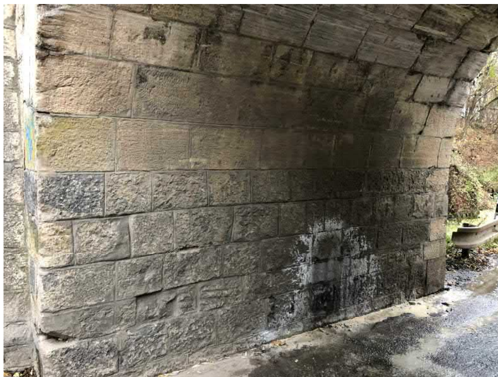
Fotografie č. 5: Pohled na opěru mostu ve směru Brno hl. n. Místy degradované spárování, mechanické poškození podhledu klenby.
